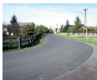
...i po remoncie
