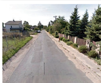
Droga w Suchoczasach przed remontem...
