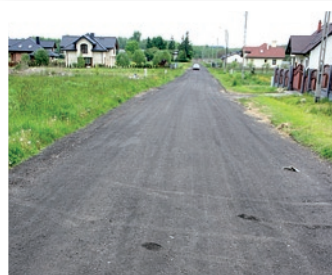
Droga w Tymienicach przed remontem...
