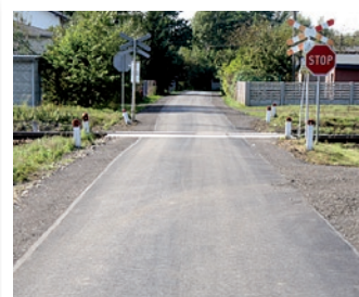
...i po remoncie
