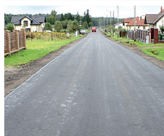
...i po remoncie
