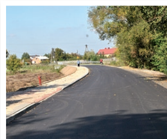
...i po remoncie
