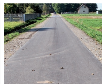
...i po remoncie
