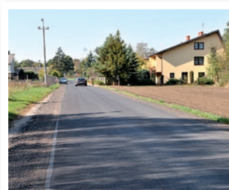
...i po remoncie
