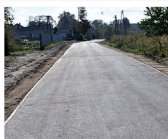
...i po remoncie
