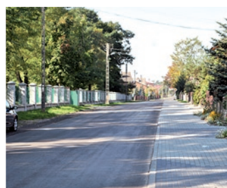
...i po remoncie
