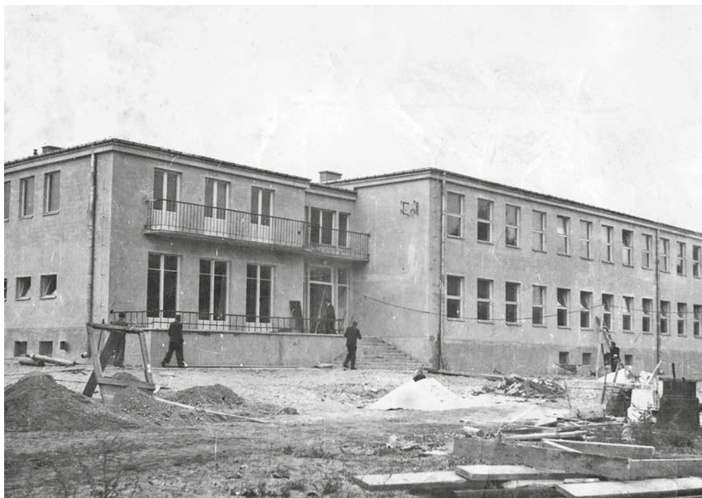
Ryc. 34. Budowa Szkoły Podstawowej w Czechach (lata 60. XX w.)
