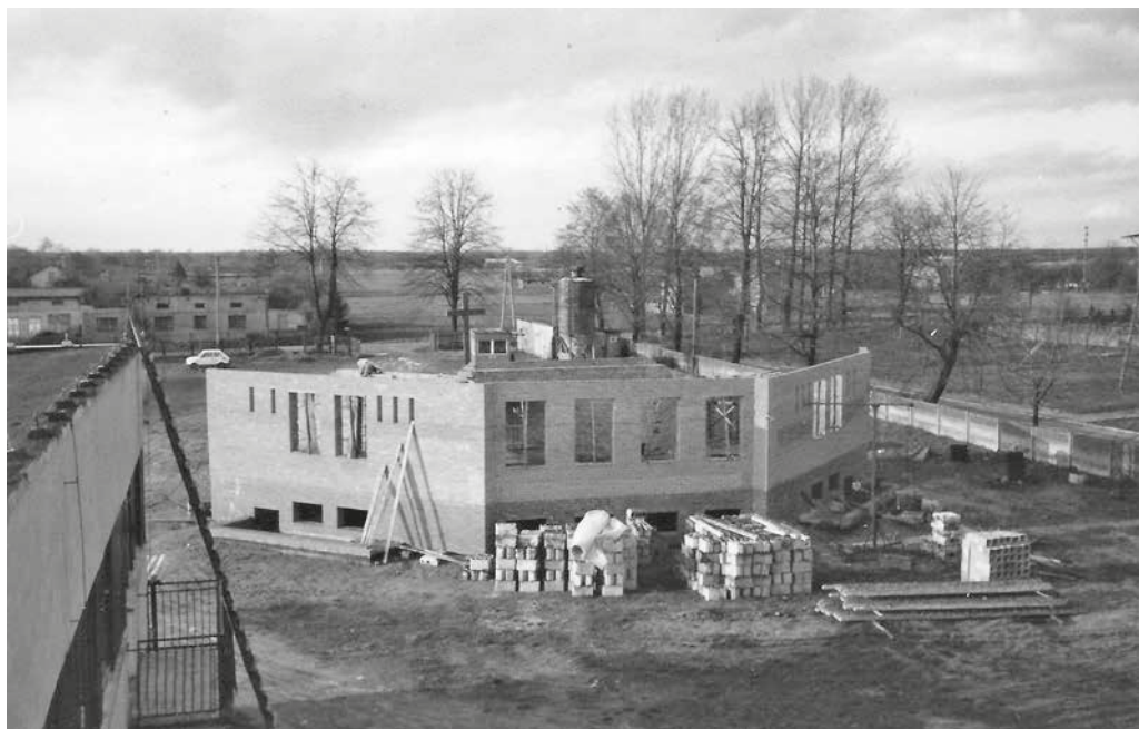
Ryc. 11. Budowa kościoła w Janiszewicach (1992)
