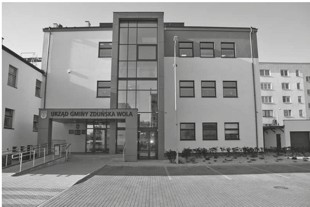
Fot. 14. Budynek Urzędu Gminy Zduńska Wola po rozbudowie, wykonawca Przedsiębiorstwo Produkcyjno-Handlowo-Usługowe Tadeusz Pędziwiatr (28 X 2017) Źródło: Archiwum Urzędu Gminy Zduńska Wola
