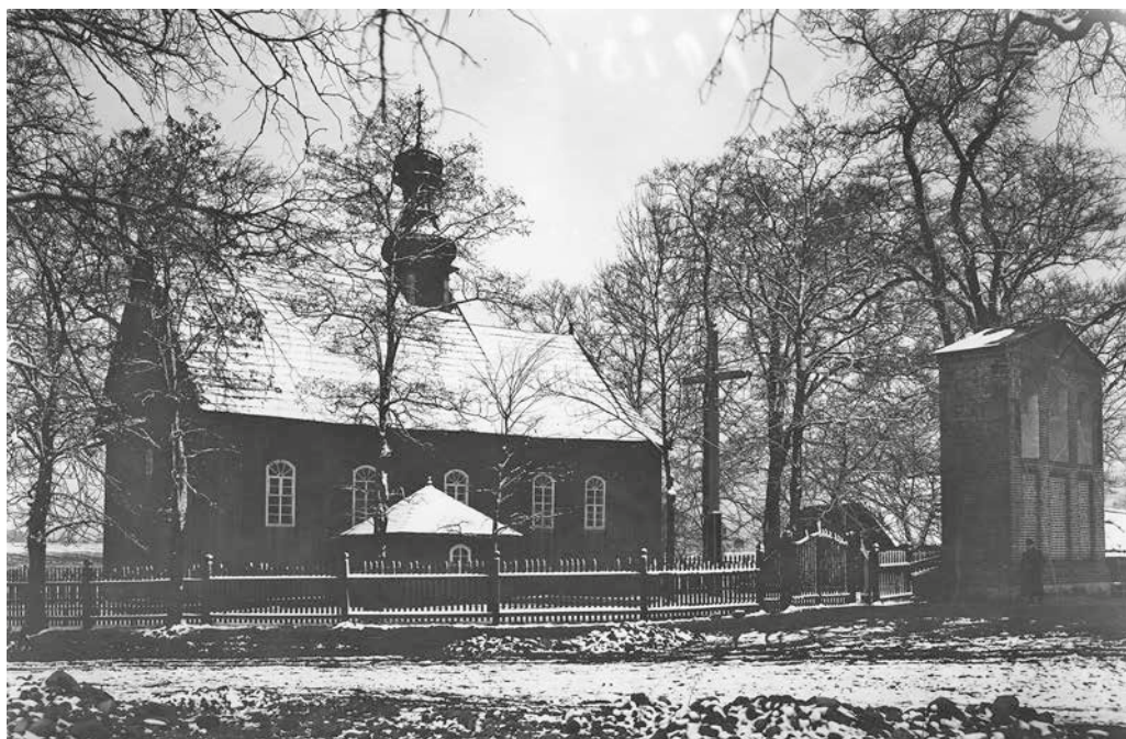
Ryc. 5. Widok na kościół i dzwonnice w Korczewie
