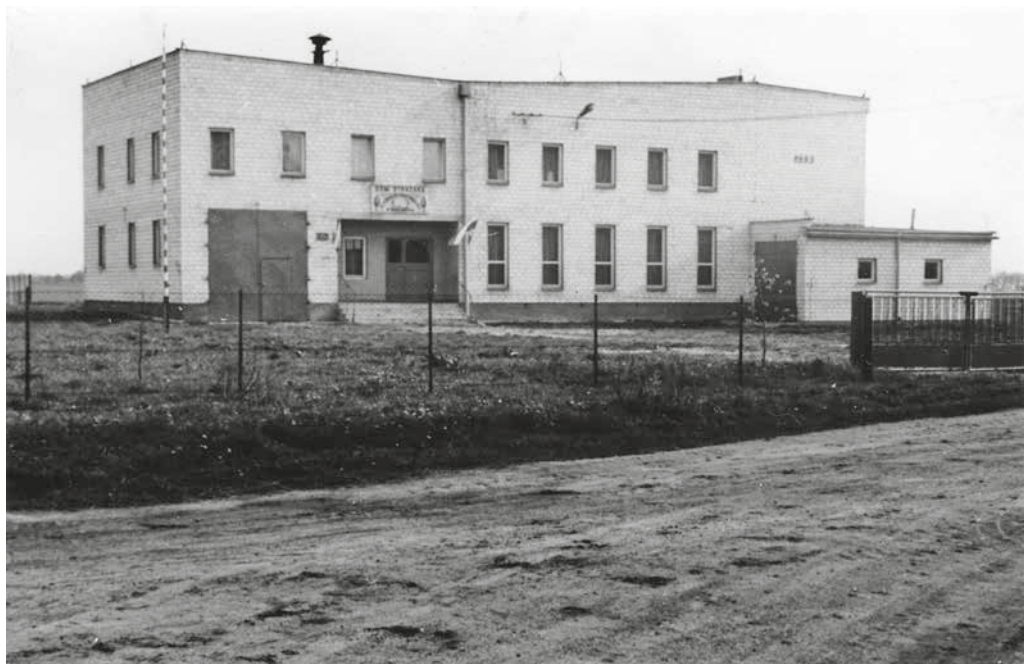
Ryc. 78. Budynek nowej strażnicy (Dom Strażaka) w Wojsławicach (1983)
