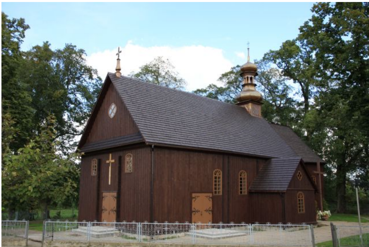
Widok od strony południowo - zachodniej
