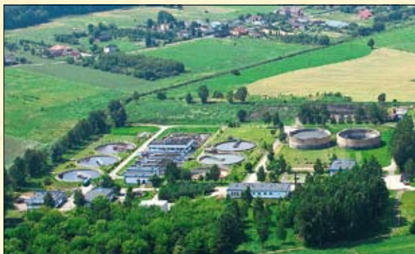
Miejska oczyszczalnia ścieków
