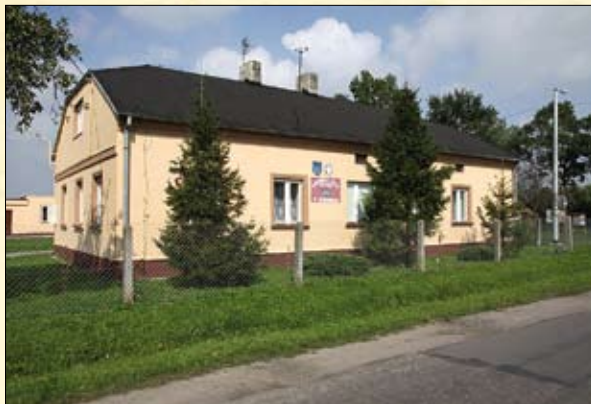
Budynek Ochotniczej Straży Pożarnej w Gajewnikach, w którym do niedawna mieściła się szkoła podstawowa
