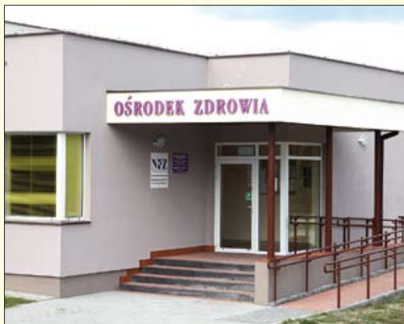
Budynek ośrodka zdrowia
