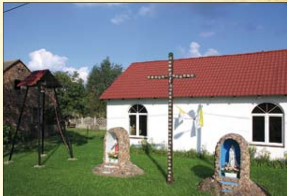
Murowana kaplica wiejska
